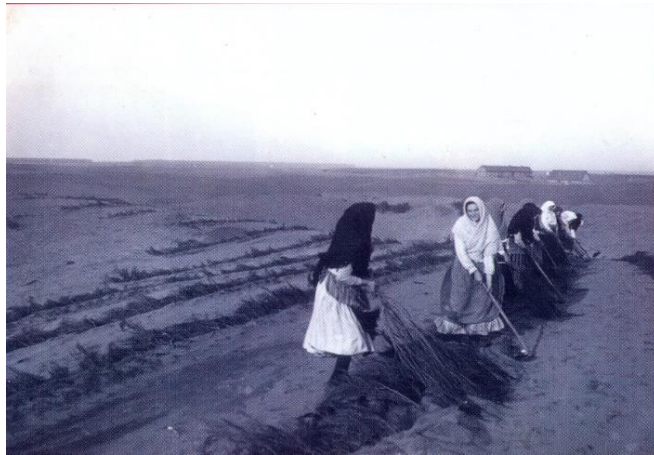
Slika 2: Radovi na pošumljavanju Pijesaka (Web 1).
