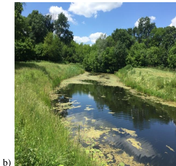
Slika 5. Crpna stanica Zlatna greda, postaja 2: a) veljača, 2016., b) svibanj, 2016.
