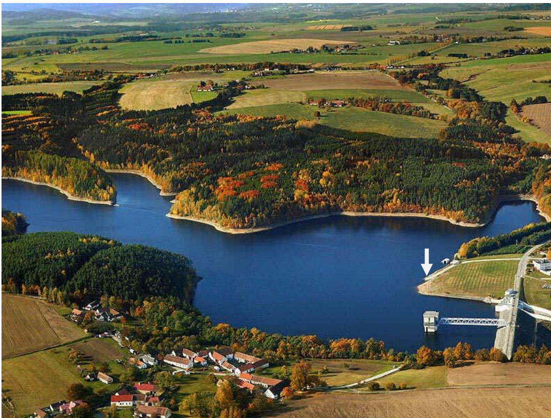
Slika 3. Fotografija rezervoara Rimov
