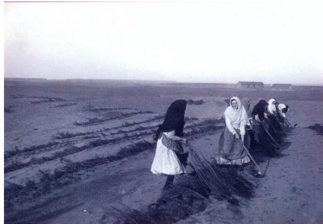
Slika 2: Radovi na pošumljavanju Pijesaka (Web 1).
