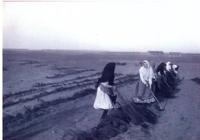
Slika 2: Radovi na pošumljavanju Pijesaka (Web 1).
