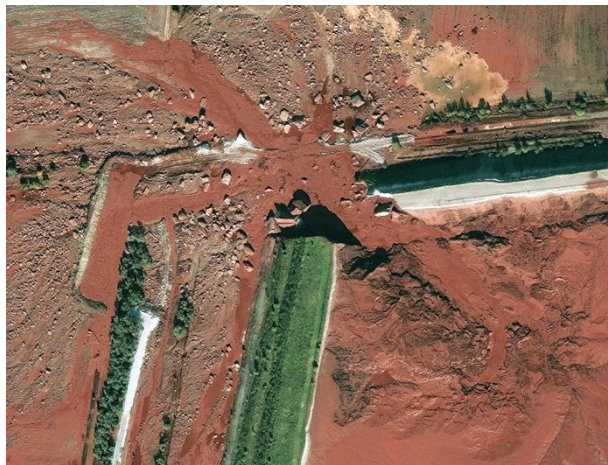
Slika 1: Satelitski snimak izlaska crvenog mulja kroz oštećeni bazen (Web 1)
