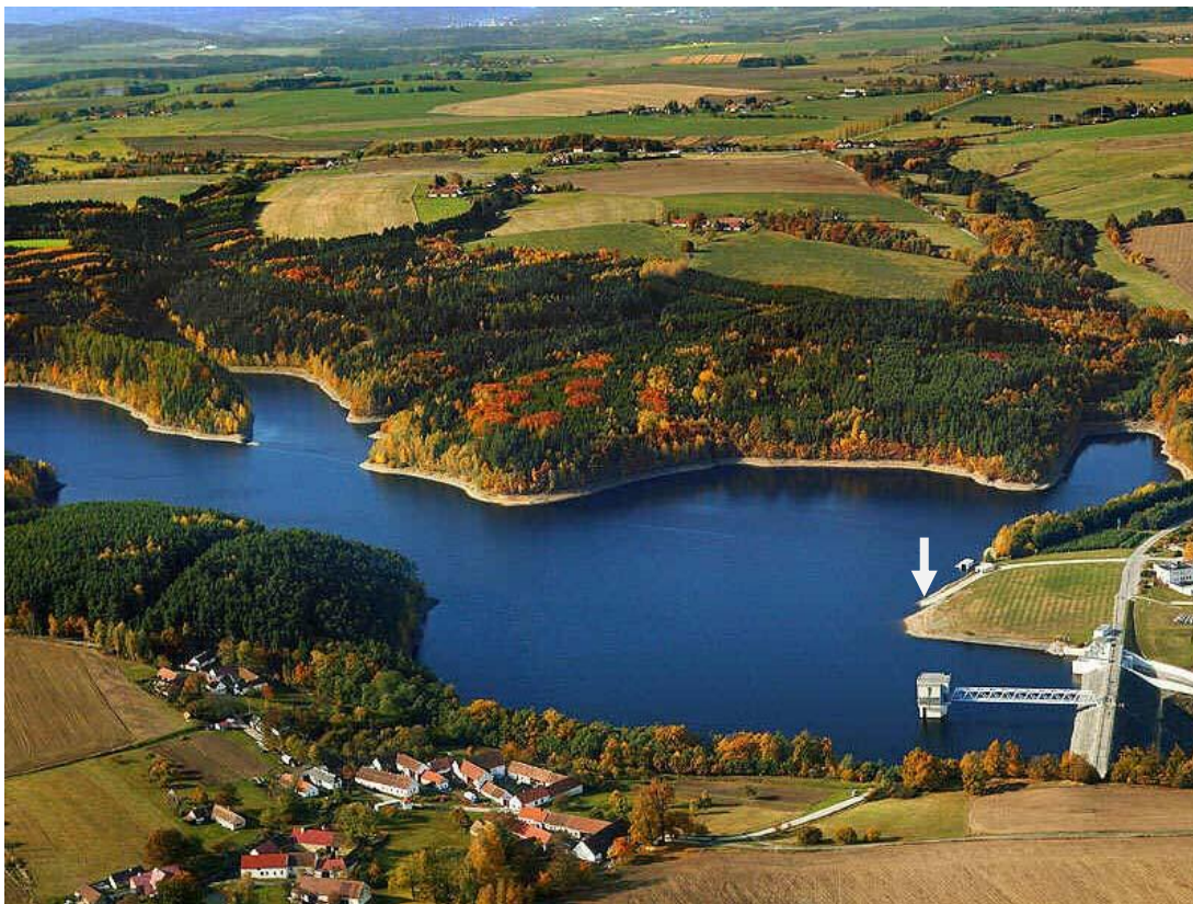
Slika 3. Fotografija rezervoara Rimov
